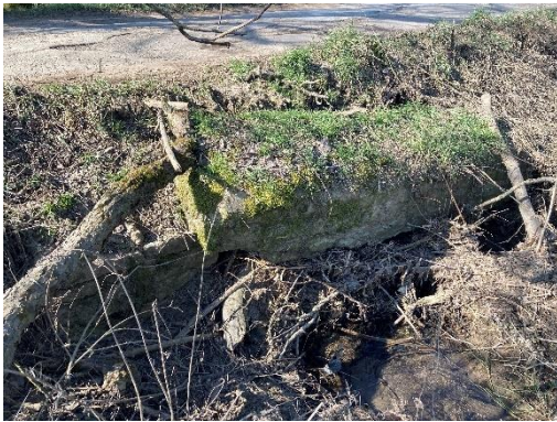
Teils eingestürzter Durchlass des Oligbach am Diersdorfer Hof
