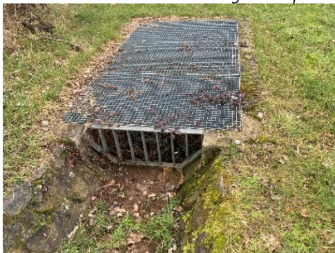
Einlaufbauwerk und Blick in das Einlaufbauwerk
