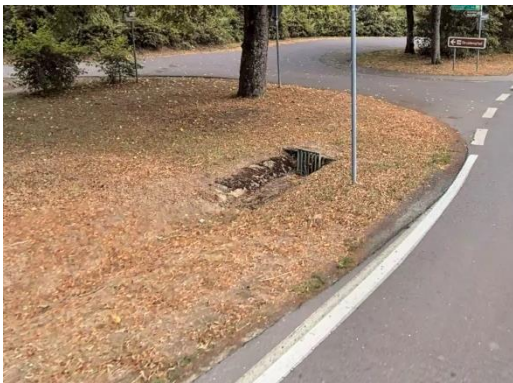
Einlaufbauwerk am Ortseingang, Quelle apple maps 2019
