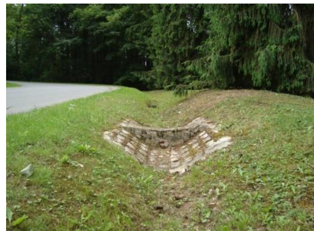
Beispiel Graben mit Querbauwerk zum Rückhalt
