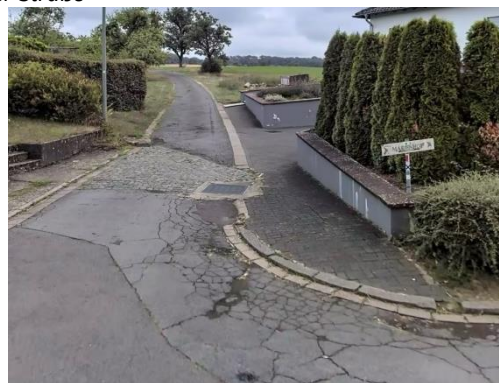
Einlauf im Straßenbereich neben der Zuwegung in Richtung Norden
