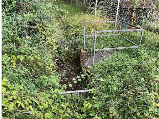
Einlaufbauwerk des Grabens
