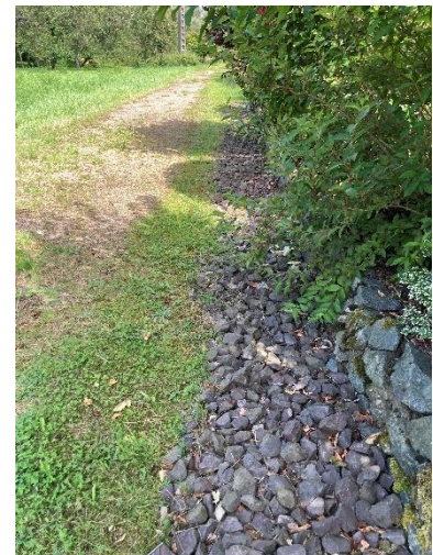
Oberflächenentwässerung über Mulden und Rinnen, „Sickerstreifen“ = Kiesstreifen
