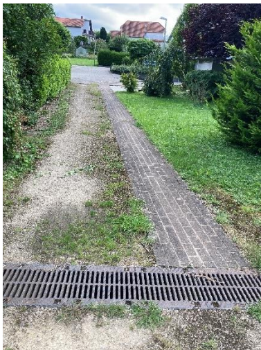
Oberflächenentwässerung über Mulden und Rinnen, „Sickerstreifen“ = Kiesstreifen
