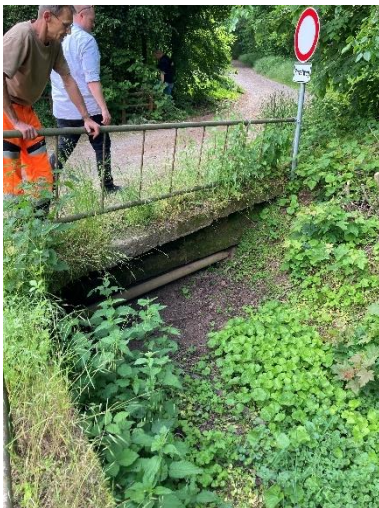
Wegekreuzung des Itzbachs im Bereich Heßmühle
