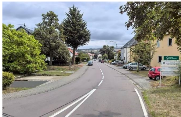
Blick n die Neunkircher Straße, Quelle apple maps 2019
