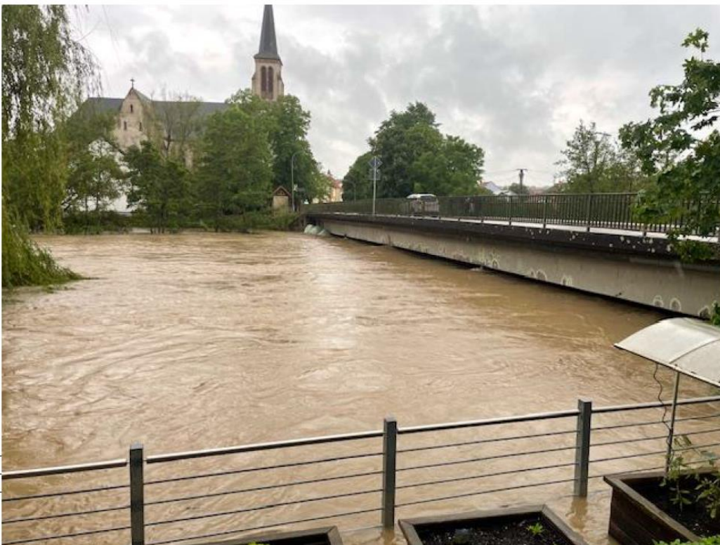
Abbildung 7: Wasserstand an der Niedbrücke in Niedaltdorf gegen 18:30 am 17.05.2024. Bildquelle: Gemeinde Rehlingen-Siersburg
