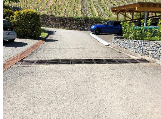
Beispiel breite Überfahrbare Entwässerungsrinne mit breiten Schlitzten.
