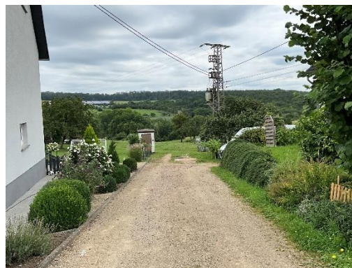
Unterhalb der Straße im Breitfeld: Freier Bereich für Notfließweg in Richtung der Grünflächen
