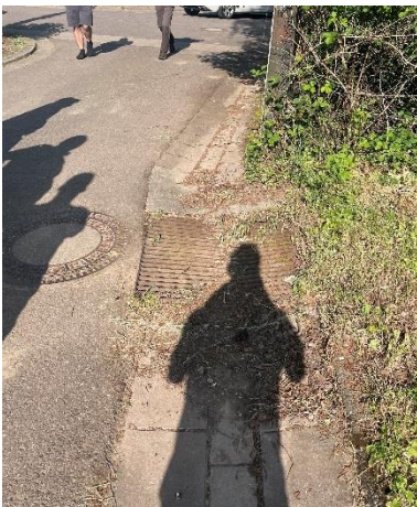
Einlauf oberhalb der Bergstraße.
