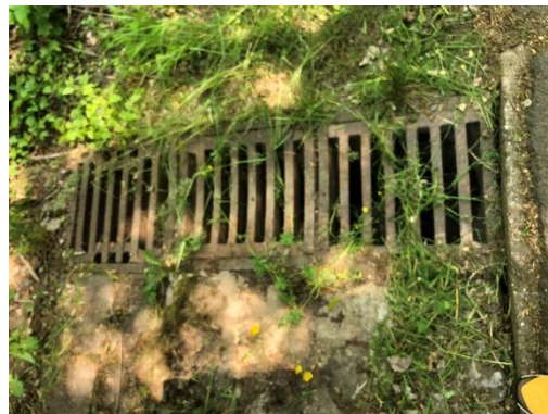
Einläufe im Bereich des Sportplatzes
