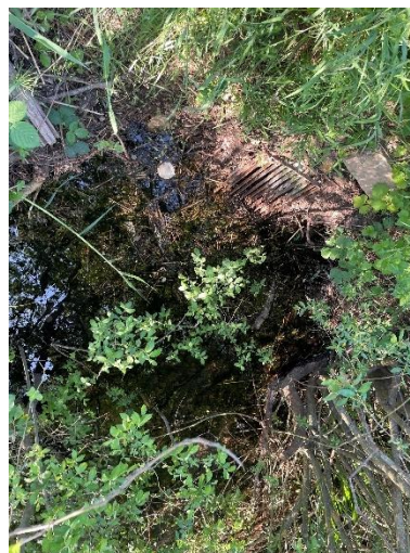
Ablauf der Weiheranlage
