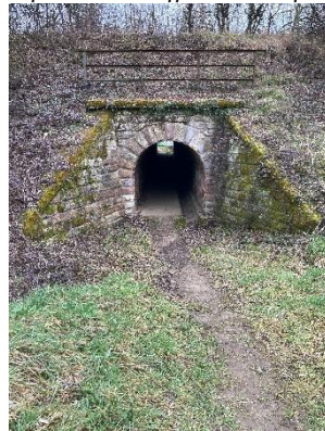
Durchlass im Bereich des Bahndamms
