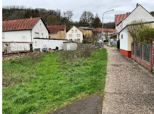
Verrohrte Gewässerstrecke des Schoppbachs
