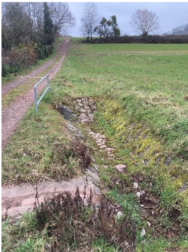
Wegedurchlass oberhalb der Bebauung (Quelle rechts apple maps 2019)
