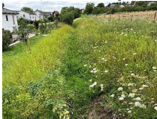
Graben oberhalb der Wohnbebauung
