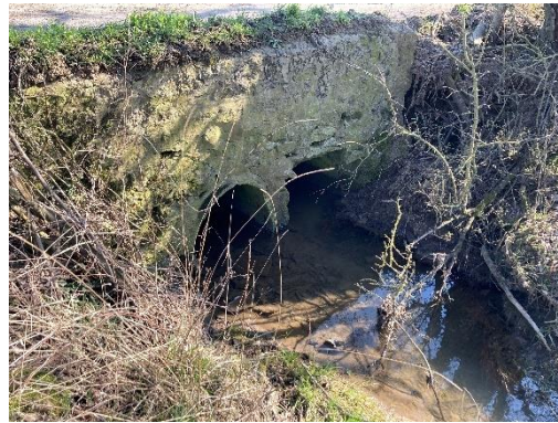
Teils eingestürzter Durchlass des Oligbach am Diersdorfer Hof
