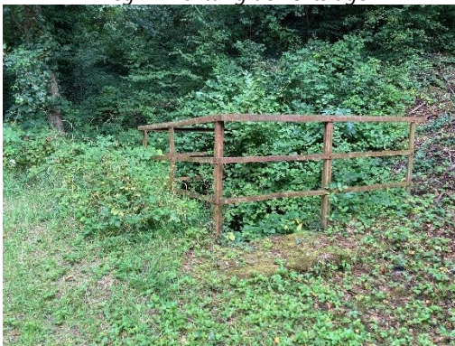
Einlaufbauwerk am Bahndamm
