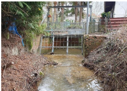
Einlaufbauwerk und Treibholzrechen am Geisbach, Brunnenstraße; Fotos teils durch Anwohner zur Verfügung gestellt
