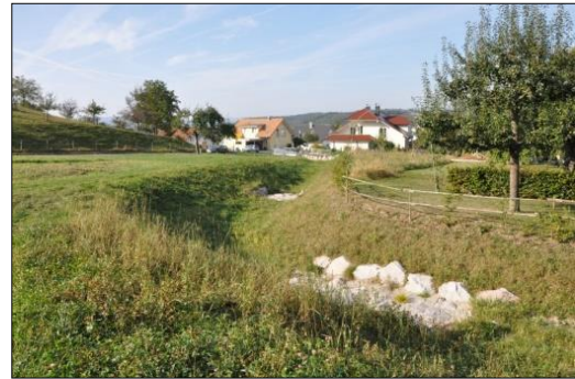
Beispiele großzügig dimensionierter Leitgräben, Wald&Corbe
