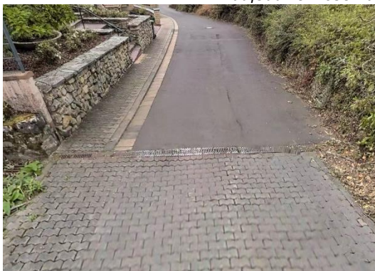
Ende der Mittelrinne und Entwässerungsrinne im oberen Bereich der Straße, Quelle: apple maps 2019
