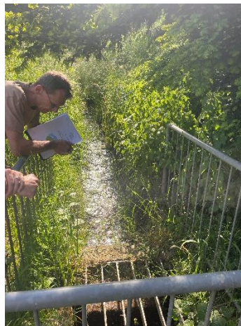
Einlaufbauwerk oberhalb Hs-Nr. 8
