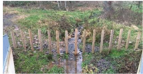
Kleinrückhaltebecken Ens Dorf am Lochbach, 2016
