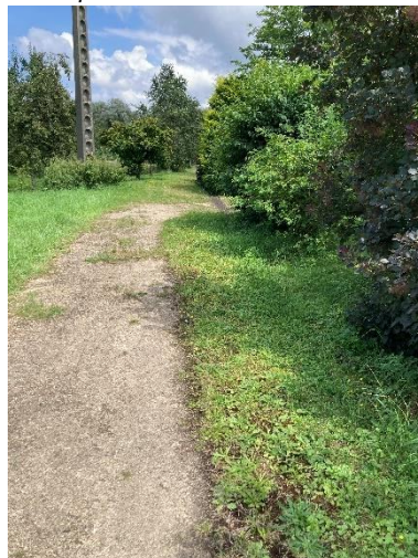
Oberflächenentwässerung über Mulden und Rinnen, „Sickerstreifen“ = Kiesstreifen
