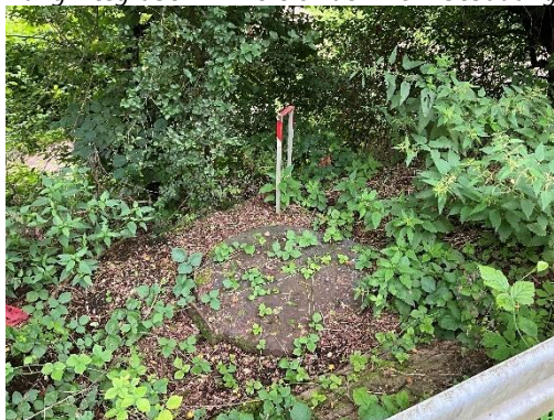
Schieberschacht an der Hochwasserschutzanlage
