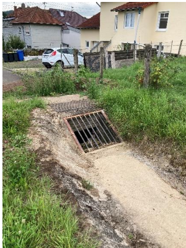
Einlaufbauwerk (links) und Tiefenlinie oberhalb (rechts)
