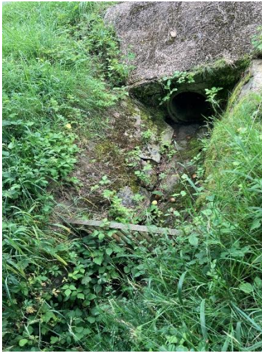
Einlaufbauwerk Scheissborn
