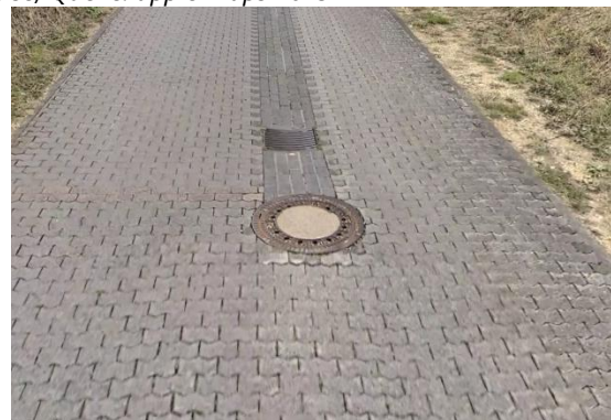
Ende der Mittelrinne und Entwässerungsrinne im oberen Bereich der Straße, Quelle: apple maps 2019
