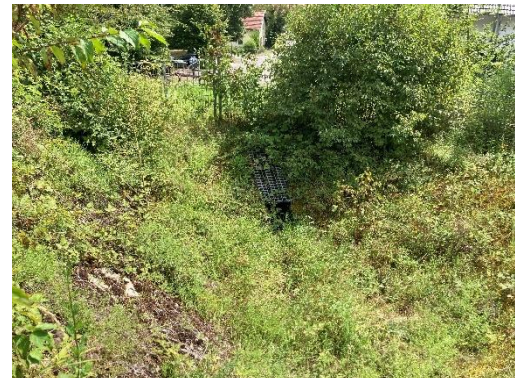
Einlaufbauwerk am Tiefpunkt des Grabens
