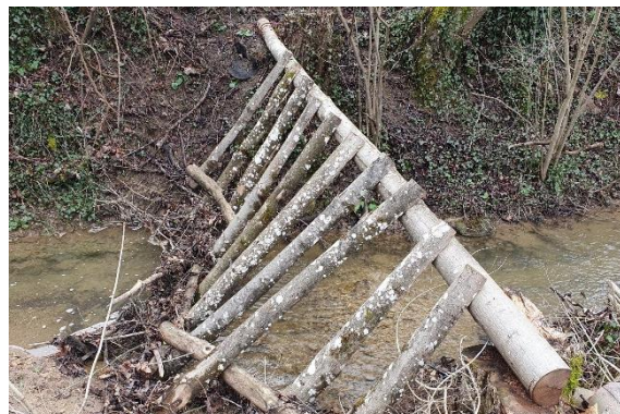
Einlaufbauwerk und Treibholzrechen am Geisbach, Brunnenstraße; Fotos teils durch Anwohner zur Verfügung gestellt
